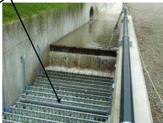
濁水処理施設（ろ過材：モールコード）
