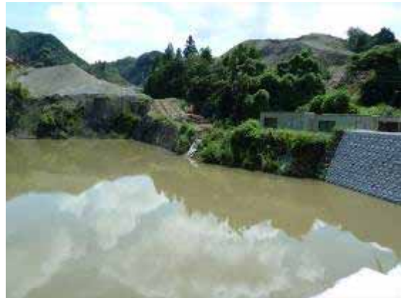
調整池天端からの眺め
