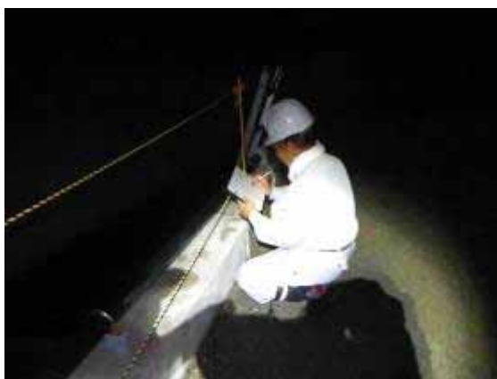
各種計測データ記録状況（夜間）
