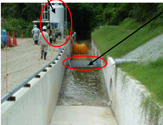
濁水処理施設全景（調整池側から望む）
