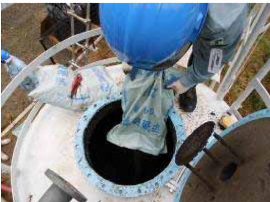
ろ過器底部に敷き詰め作業中のろ過砂利の状況
