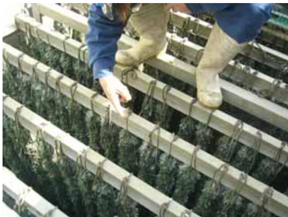
洗浄ろ過材の再設置後の状況
