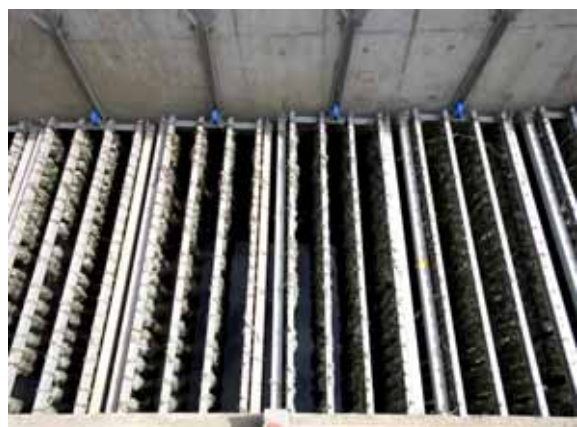
洗浄ろ過材の再設置後の状況
