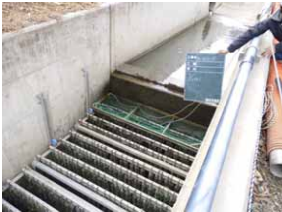
流入口のろ過材に設置した枝葉等 流入防止ネット（全景）
