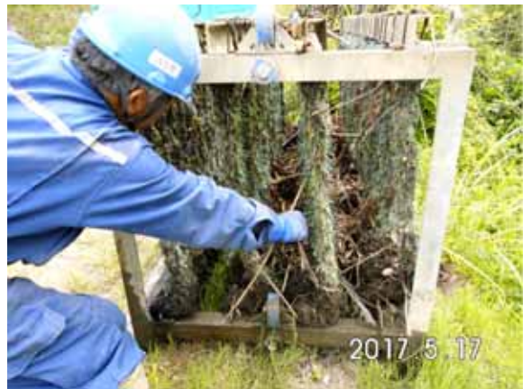
枝葉等の除去作業光景
