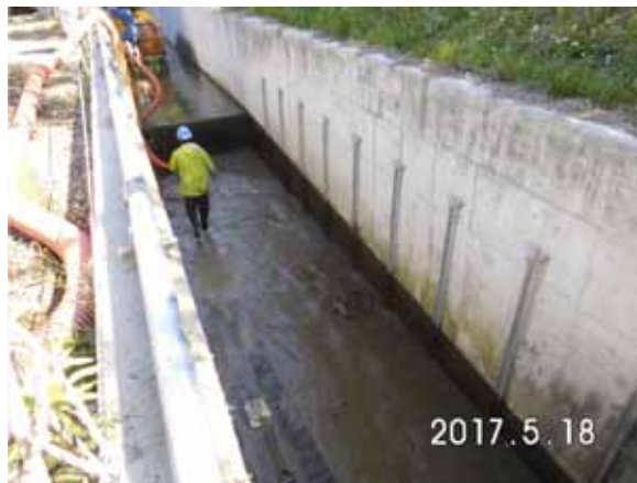
水路底部の泥水吸引作業の様子
