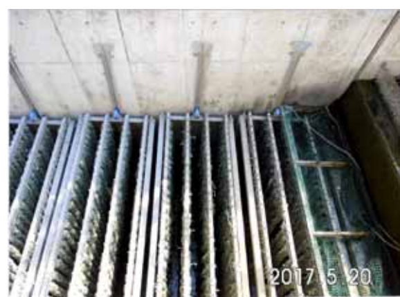
設置完了後の水路に取り付けられた 洗浄後のモールコード
