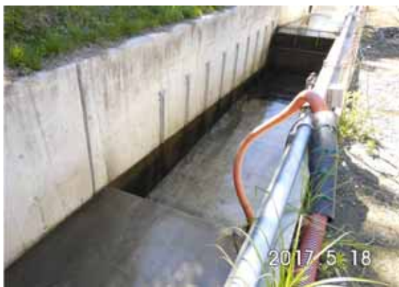
洗浄後の水路の様子
