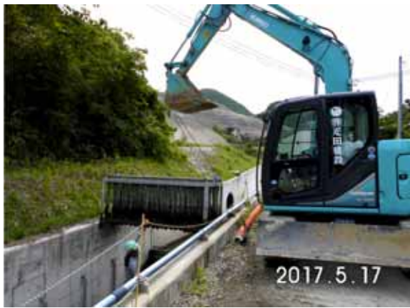
洗浄前モールコードの水路からの引き上げ
