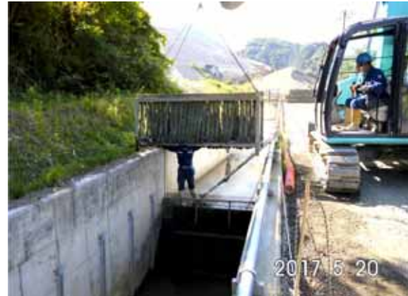
洗浄されたモールコードの水路への設置
