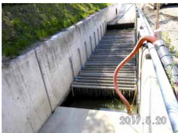
設置完了後の水路に取り付けられた 洗浄後のモールコード
