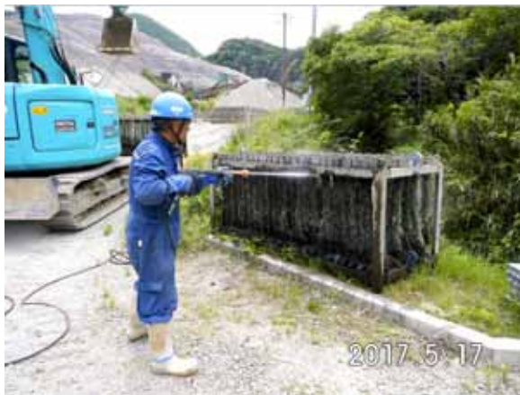
高圧水によるモールコードの洗浄
