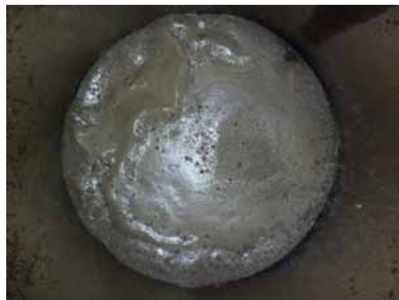
交換前の自動活性ろ過器の内部の状況
