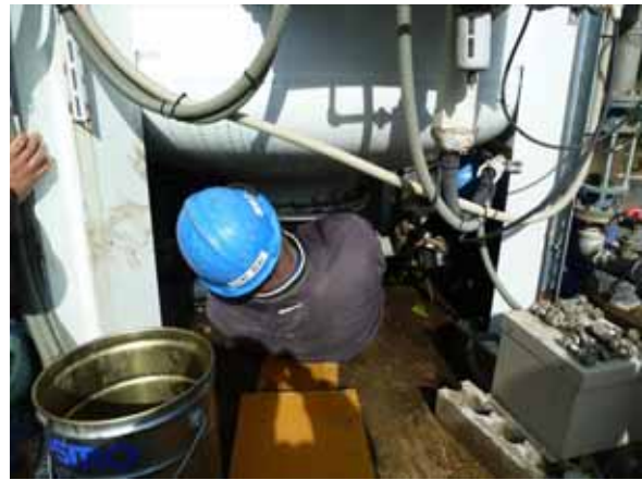
ストレーナー交換前作業の様子
