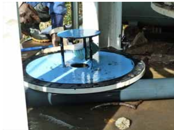
ストレーナー交換前作業の様子
