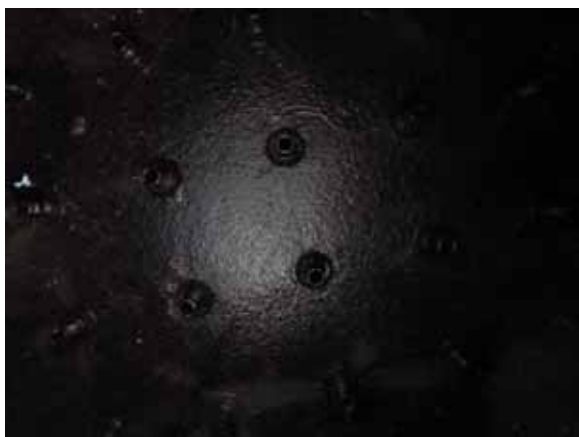
ストレーナー取付内部の様子
