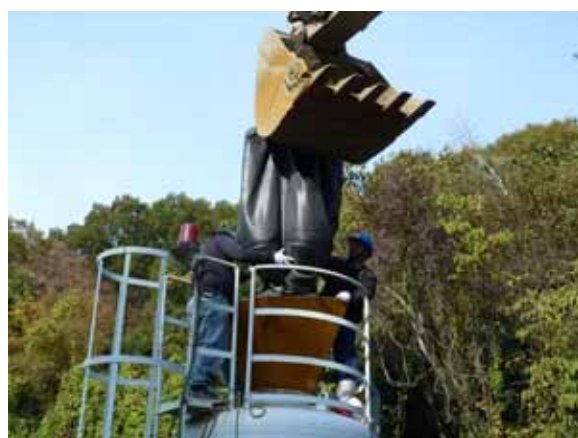
活性炭の自動活性ろ過器への搬入の様子
