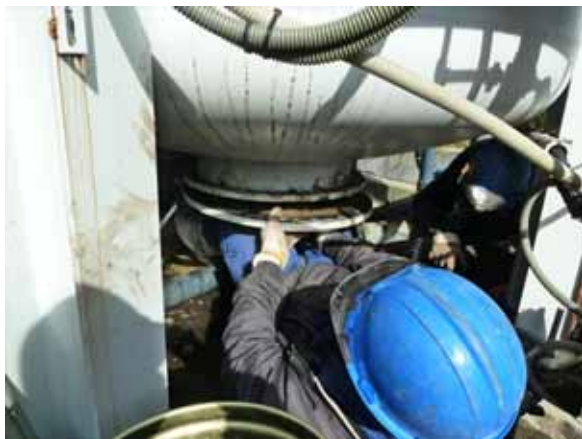
ストレーナー交換前作業の様子
