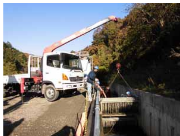
洗浄・天日干し後のモールコードの 水路への設置状況
