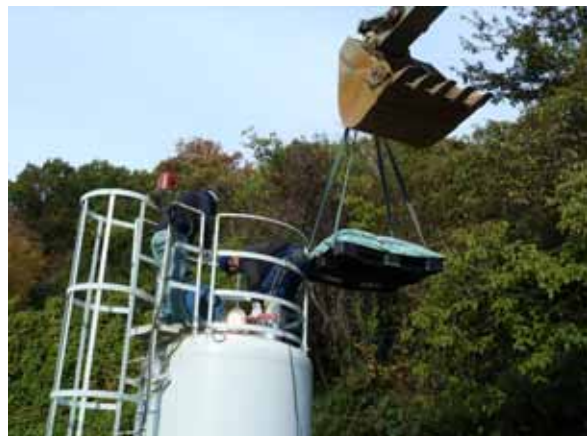
ろ過砂利の自動活性ろ過器への搬入状況
