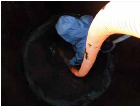
活性炭等の吸引状況の確認作業
