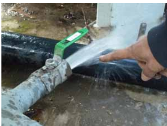
活性炭交換後の試運転状況の様子
