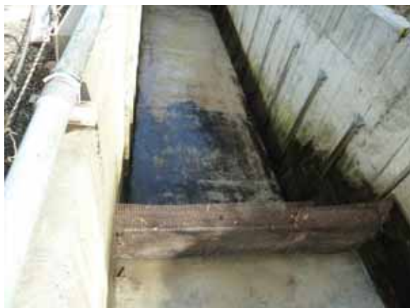
泥水吸引・洗浄後の水路の光景
