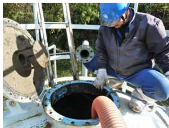
ポンプ車による活性炭等の吸引状況
