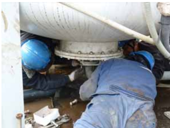
自動活性ろ過器底部の蓋取付の様子
