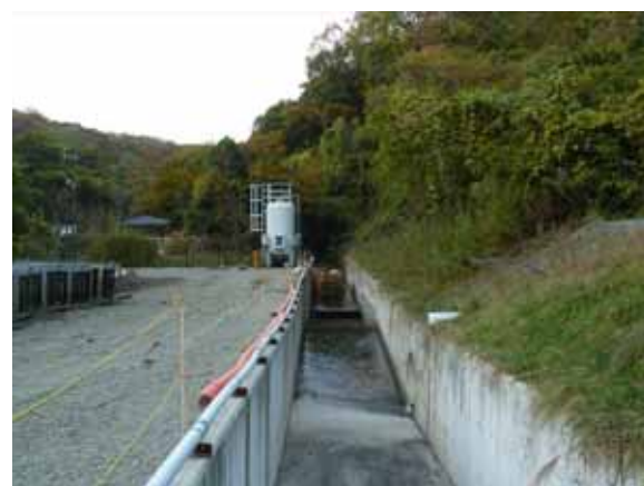
活性炭等交換後・試運転完了後の自動活性ろ過器及び水路の光景
