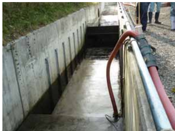
泥水吸引・洗浄後の水路の光景
