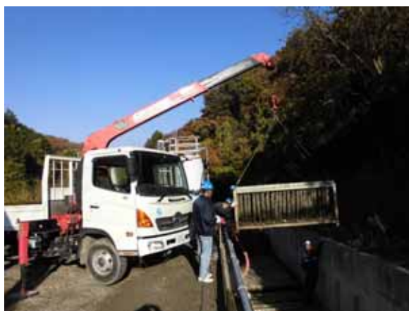
洗浄・天日干し後のモールコードの 水路への設置状況
