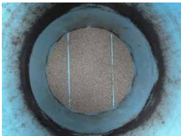
自動活性ろ過器底部に敷き詰められたる過砂利
