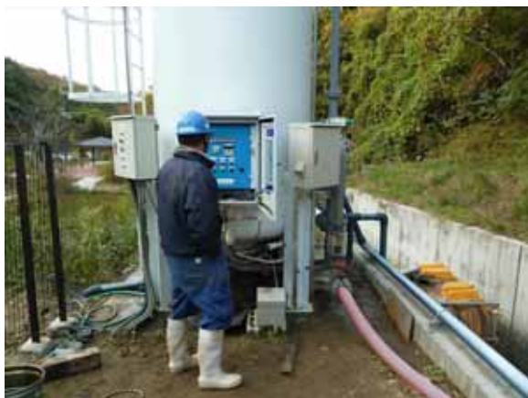
活性炭交換作業完了後の様子
