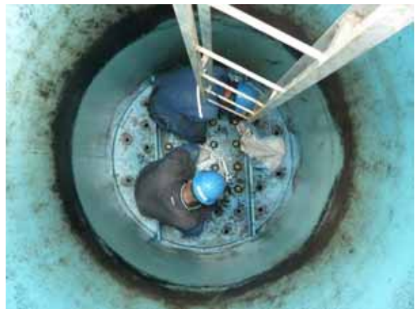
ストレーナー設置完了後の様子
