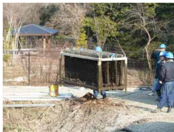
モールコードの引き上げ作業の様子
