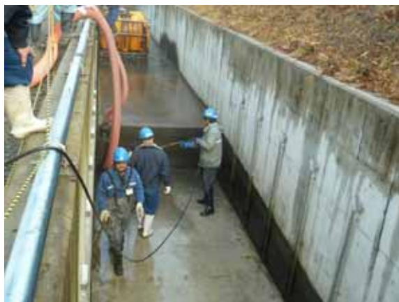
泥水吸引後の高圧水による水路の洗浄
