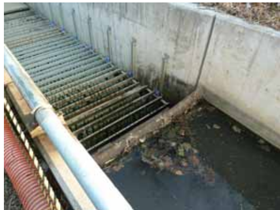
枝葉等の除去・洗浄前のモールコード
