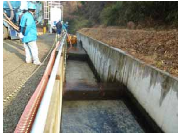
泥水吸引・洗浄後の水路の光景
