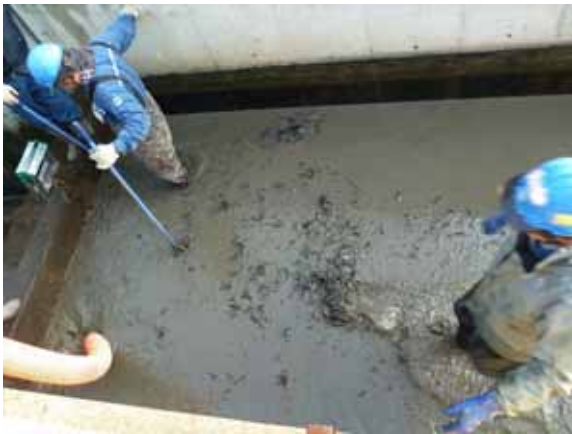
水路に貯まった泥水の吸引光景
