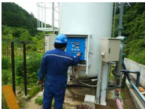
自動活性ろ過器の逆洗浄作業の様子
