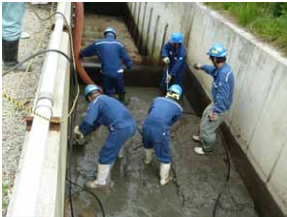
水路に貯まった泥水の吸引光景
