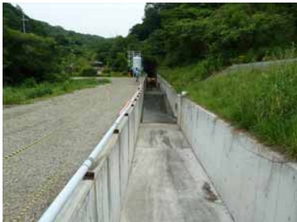
洗浄前のモールコード（水路全景）
