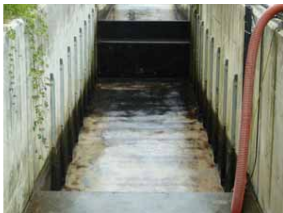
泥水吸引・洗浄後の水路の光景
