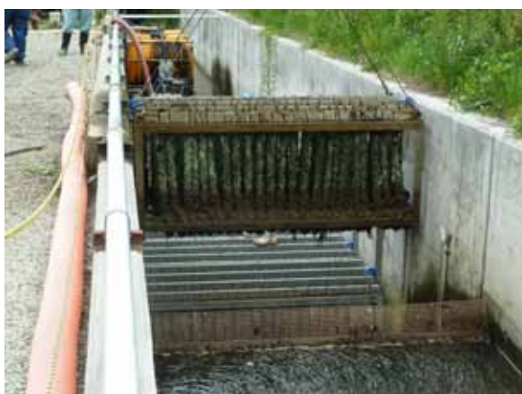
モールコードの引き上げ作業の様子
