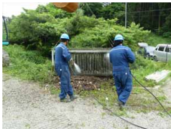
高圧水によるモールコードの洗浄の様子
