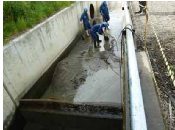
水路に貯まった泥水の掻き集め光景
