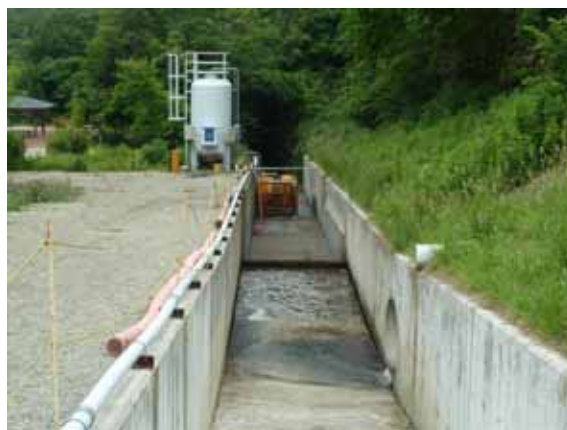
洗浄作業後の通水の様子
