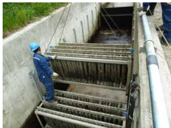
洗浄・天日干し後のモールコードの 水路への設置状況
