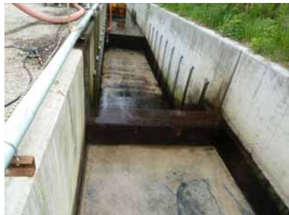
泥水吸引・洗浄後の水路の光景
