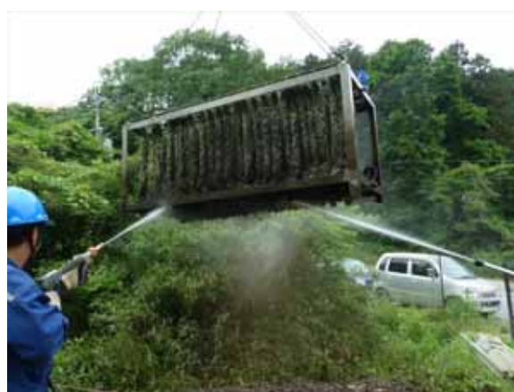
高圧水によるモールコードの洗浄の様子
