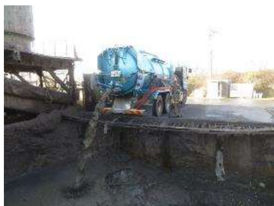
<高圧水による水路洗浄の様子>
