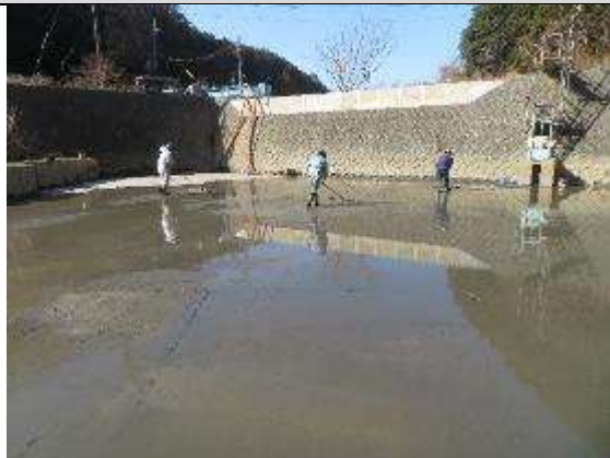
<浚渫（調整池内の高圧水洗浄）作業の様子>
