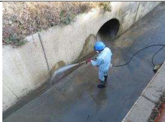
<高圧水による水路洗浄の様子>
