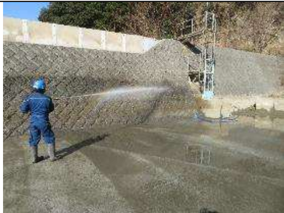
<浚渫（調整池内の高圧水洗浄）作業の様子>
