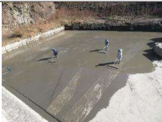
<浚渫（調整池底部の洗浄）作業の様子>
