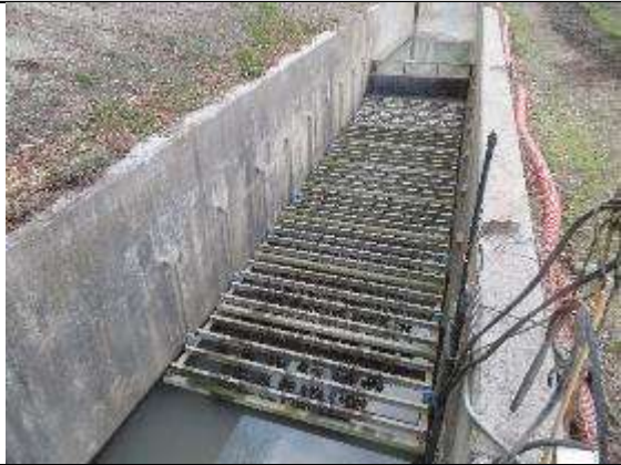
<水路に取り付けられた洗浄後のモールコード本体等の様子>
