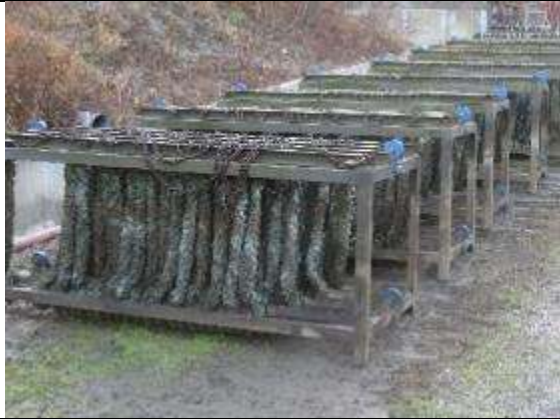
<水路に取り付けられた洗浄後のモールコード本体等の様子>
