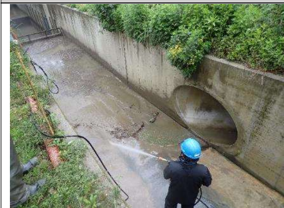
＜高圧水による水路洗浄の様子＞
