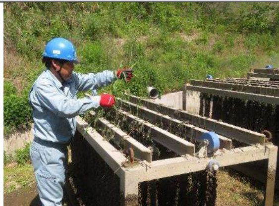
<高圧水によるモールコード洗浄の様子>
