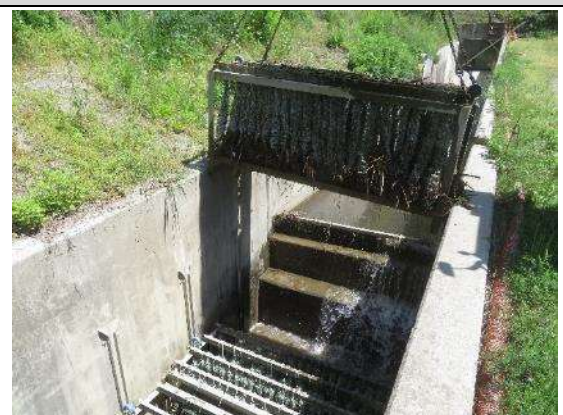
＜モールコード等の引き上げ作業の様子＞
