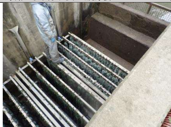
＜自動活性ろ過器の逆洗浄操作作業の様子＞
