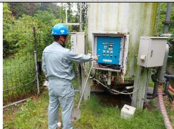
＜自動活性ろ過器の逆洗浄操作作業の様子＞
